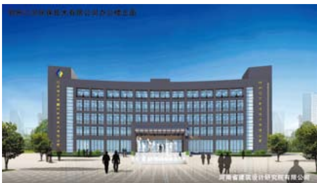
郑州江河环保技术有限公司办公大楼
