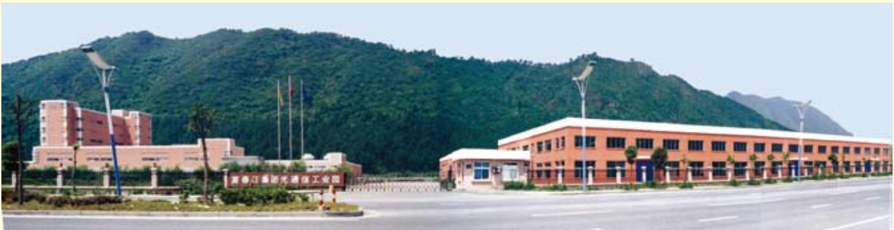
光通信园区全景
