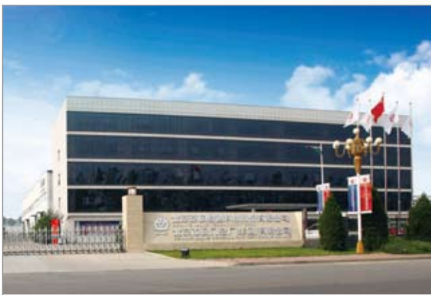
公司总部大门和办公楼
