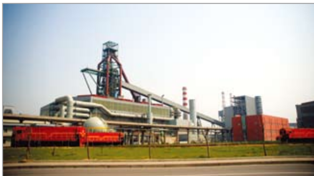
2010年9月，首钢建设集团施工的京唐2#5500高炉顺利通过鲁班奖验收
