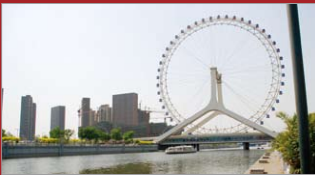
首钢建设集团施工的慈海大桥为天津市增添了新的城市景观
