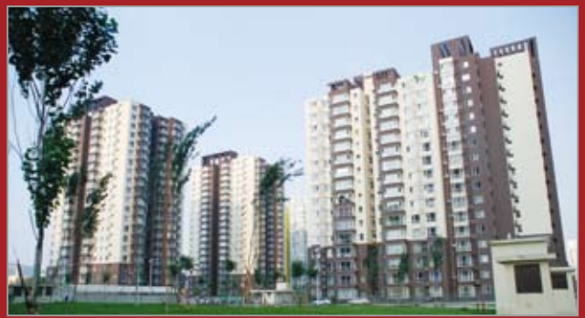
首钢建设集团参与施工的北京第一批两限房之一枫景苑小区
