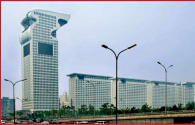
首钢建设集团承建的七星摩根大厦以其奇特的造型、复杂的钢结构施工工艺成为北京的新地标
