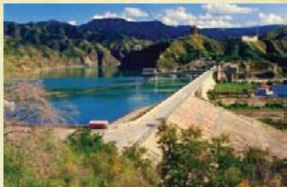
刘家峡水电站
