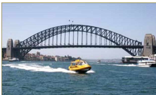
《悉尼港海湾大桥》
