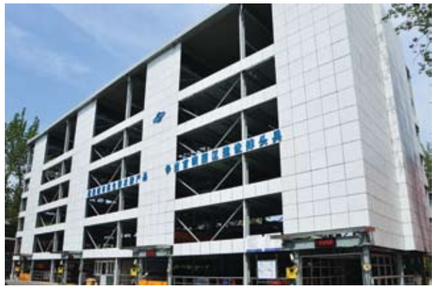
首建立体车库。
