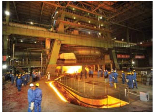
首钢京唐公司1号高炉通过2号出铁口第一次出铁水。
