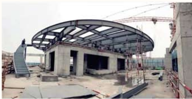
正在建设的港泰·通航大厦楼顶停机坪
