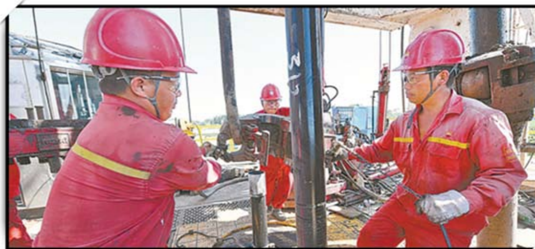
抚顺石化员工坚守60万吨/年酮苯脱油装置扩能改造工程一线。
